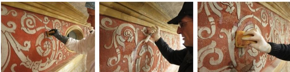
**Bild 3-1** Konservatorische Restaurierung der Fassade.
