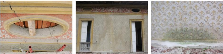
**Bild 1-2** Schäden an der – verhältnismäßig gut erhaltenen – Fassade durch Risse (links), Abmehlungen (mitte) und Feuchteschäden (rechts) im Sockelbereich.
